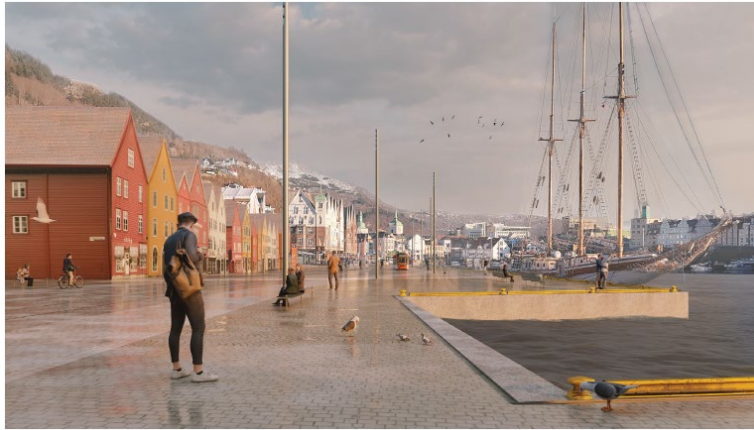
Figur 2 - Illustrasjonen viser ny situasjon langs Bryggen, sett fra Dreggekaien. Brosteinsdekke i banetrasé og sykkelfelt er utformet som en del av bygulvet.
